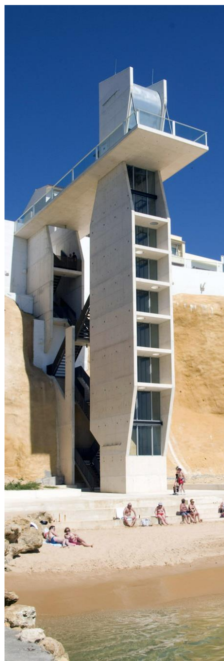
L'ascenseur de Peneco
